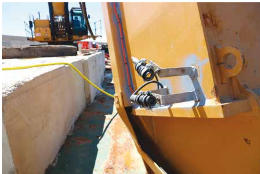
PER INDIVIDUARE IL PUNTO MIGLIORE DOVE ATTACCARE I PLINTI DA DEMOLIRE SONO STATE INSTALLATE DELLE SPECIFICHE TELECAMERE SUL BRACCIO DELL'ESCAVATORE CAT 390DL
