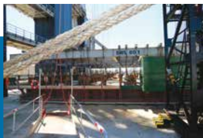
IL RIZZAGGIO DELL'ESCAVATORE È STATO REALIZZATO MEDIANTE TORNICHETTI E L'INSTALLAZIONE DI QUATTRO TACCHE SU CUI VIENE DIRETTAMENTE SALDATO IL CARRO
