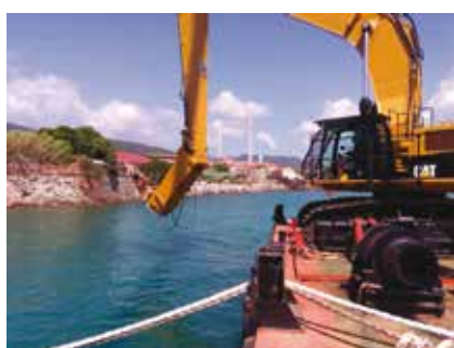
▲ L'ESCAVATORE CATERPILLAR 390DL È POSIZIONATO SUL PONTONE "GIULIA I°", DA DOVE PUÒ RAGGIUNGERE IL PUNTO ESATTO DELL'INTERVENTO SUBACQUEO
