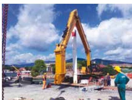
▲ L'ESCAVATORE CATERPILLAR 390DL È POSIZIONATO SUL PONTONE "GIULIA I°", DA DOVE PUÒ RAGGIUNGERE IL PUNTO ESATTO DELL'INTERVENTO SUBACQUEO
