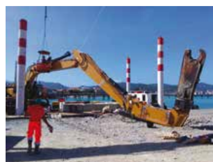
▲ L'ESCAVATORE CATERPILLAR 390DL È POSIZIONATO SUL PONTONE "GIULIA I°", DA DOVE PUÒ RAGGIUNGERE IL PUNTO ESATTO DELL'INTERVENTO SUBACQUEO
