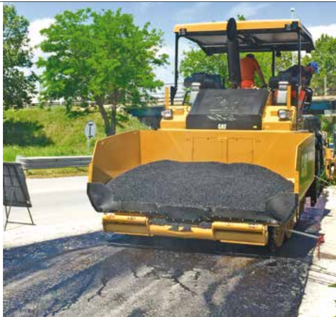
2. La AP500F al lavoro sulla Fermana Faleriense
