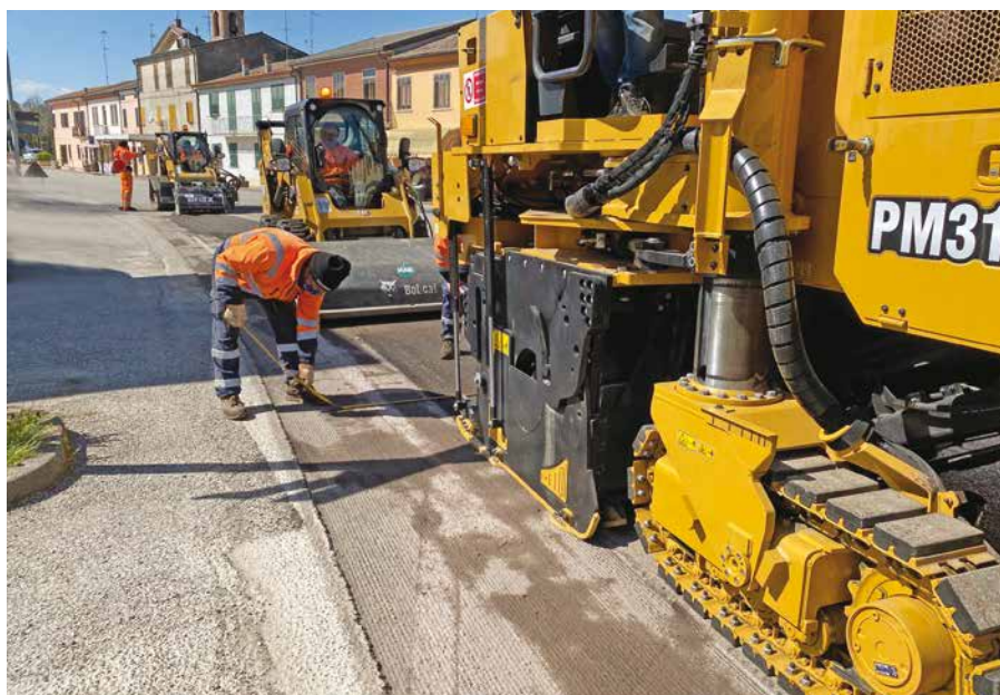
5. La fresatrice cingolata PM310, che l'Impresa utilizza per le trincee più lunghe, al fine di velocizzare i tempi di lavorazione
