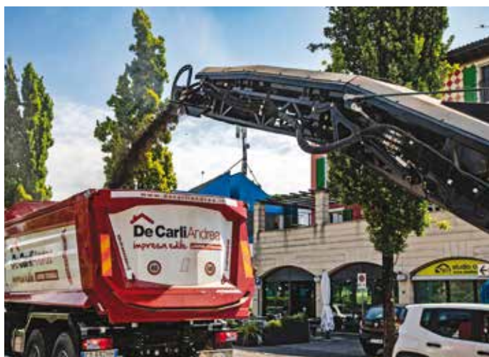
6. L'efficiente convogliatore di raccolta per l'esportazione del materiale
