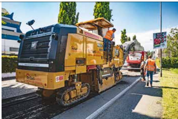
2. L'asportazione del manto di usura con erogazione di potenza ottimizzata
