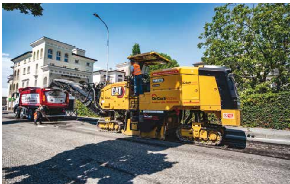
5. La marcia regolare della fresa con il giusto assetto attraverso i sensori di rilevamento della posizione
