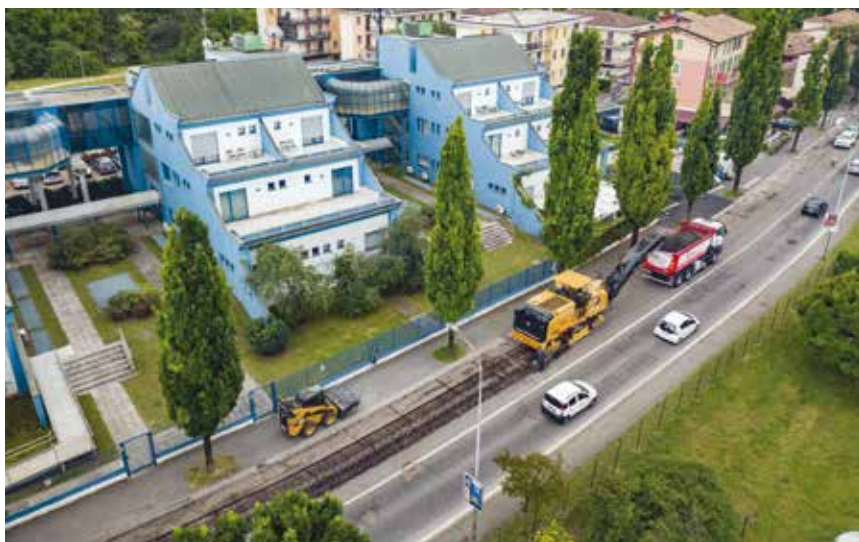
1. L'intervento di fresatura a freddo con la PM820 Next Gen sulle strade di Crema
