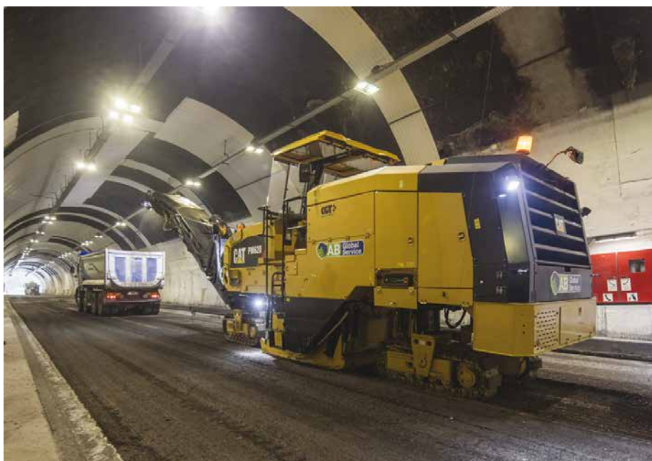
1. La fresatrice a freddo PM620 cingolata di Caterpillar al lavoro nella galleria Corchia Sud
